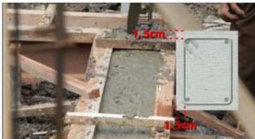
Gambar 19. Balok Pengikat/ Sloof
