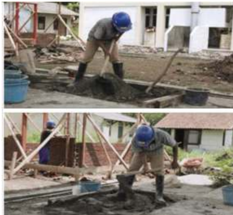
Gambar 8. Proses Pencampuran Mortar
