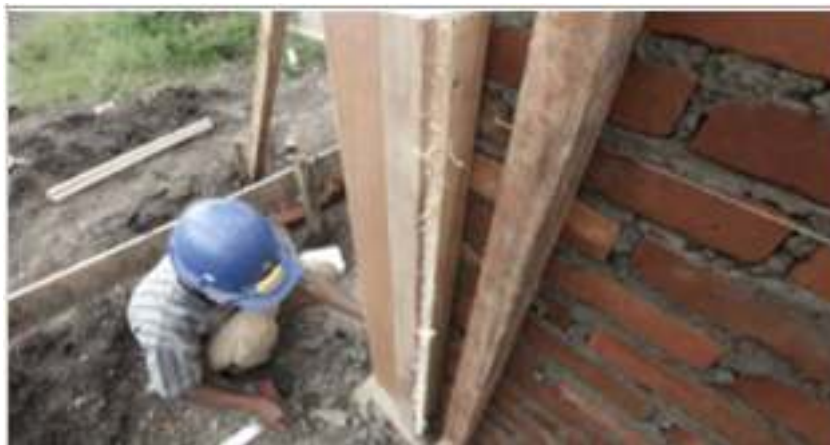
Gambar 55. Pemasangan Cetakan/ Bekisting Untuk Kolom
