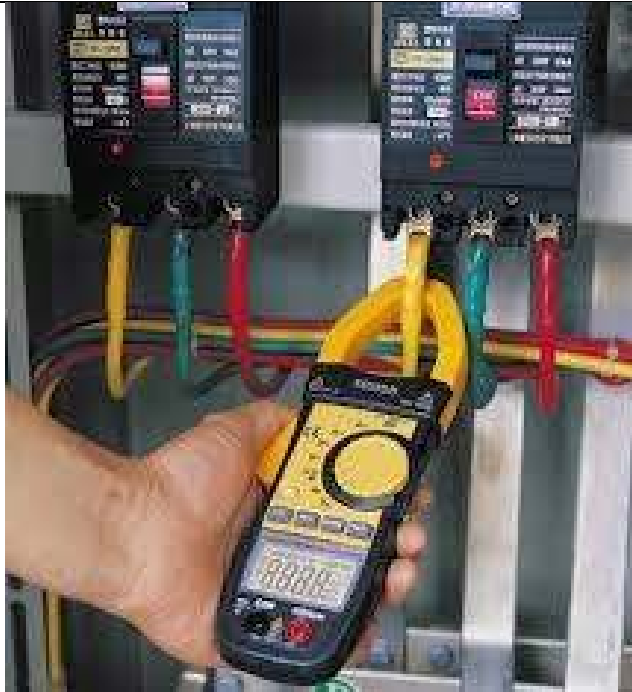
Ilustrasi Pemeriksaan menggunakan Clamp Meter
