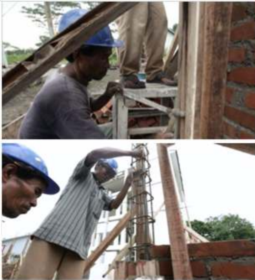
Gambar 57. Pemadatan Beton Dengan Memukul-mukul Cetakan/ Bekisting dan Campuran Beton Dirojok Menggunakan Besi atau Bambu
