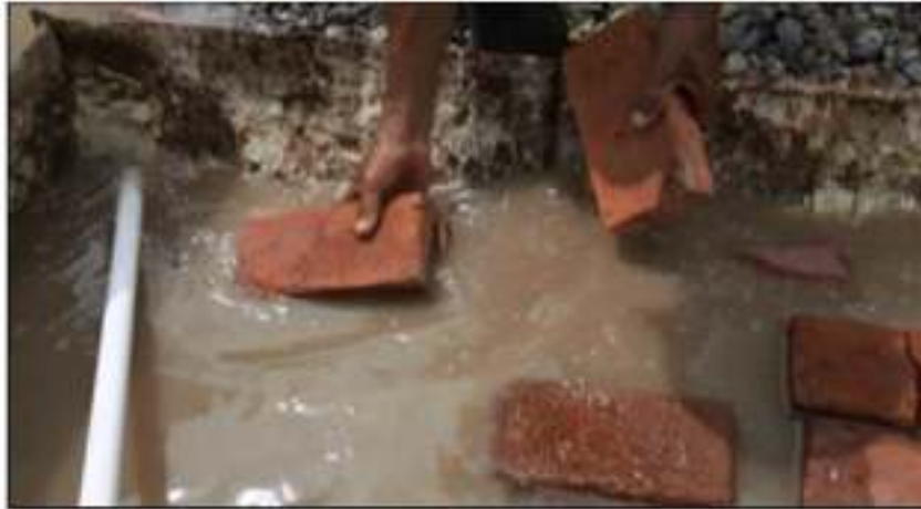
Gambar 15. Perendaman Batu Bata Sebelum Dipasang
