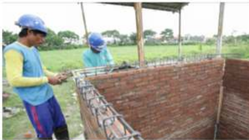
Gambar 58. Pengecoran Balok Pengikat/ Sloof
