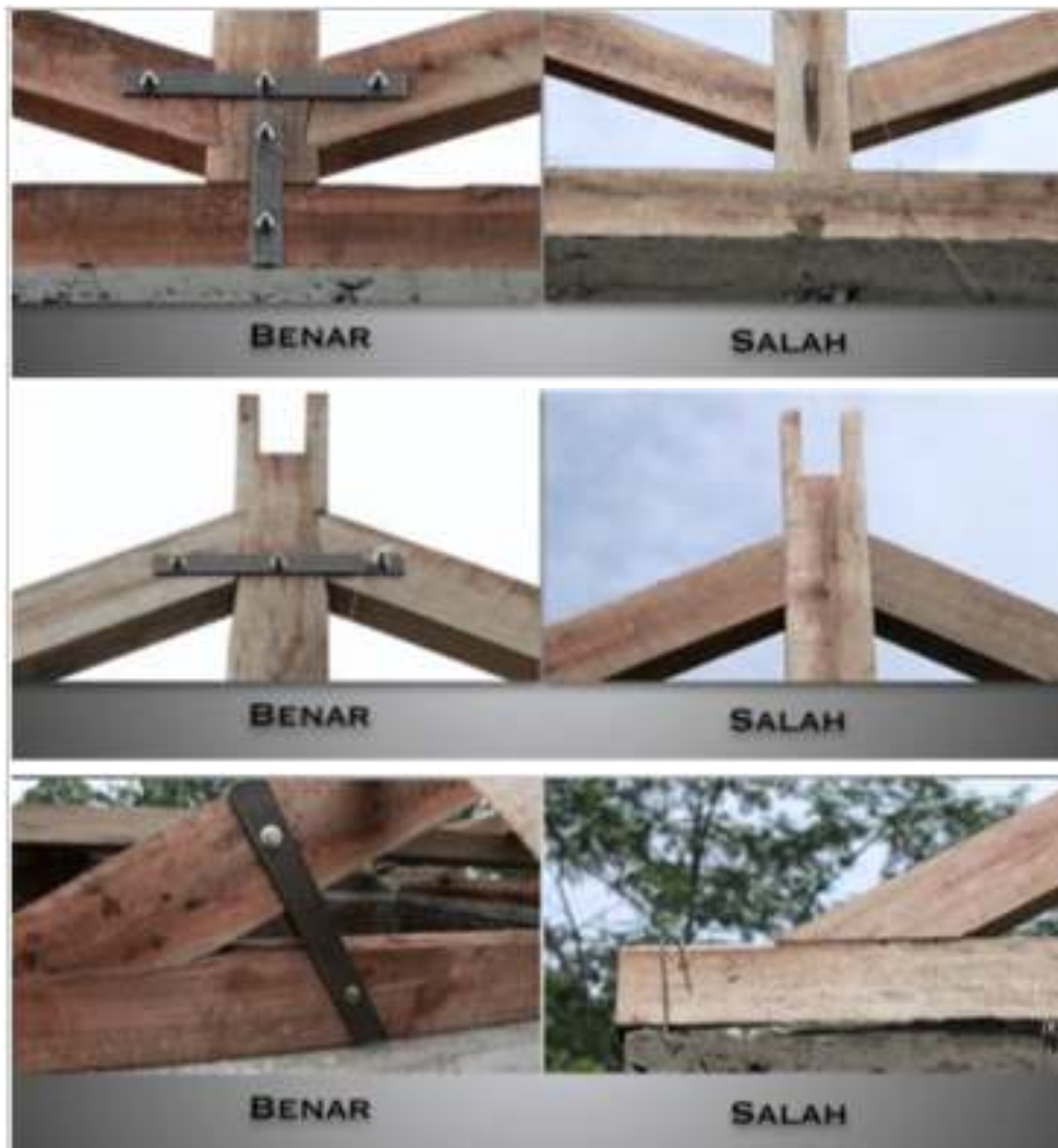
Gambar 29. Pemasangan Plat Baja Pada Kuda-kuda Kayu
