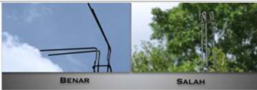
Gambar 49. Tulangan Kolom Yang Akan Dibengkokkan Ke Dalam Balok Keliling/ Ring
