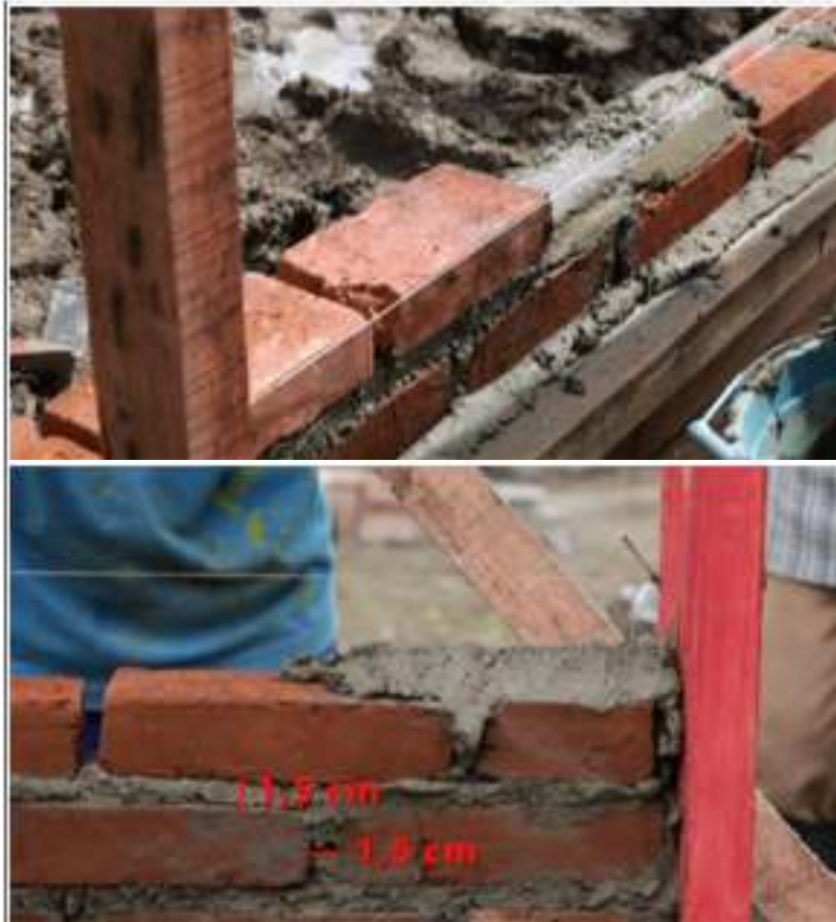
Gambar 41. Proses Pemasangan Batu Bata Untuk Dinding
