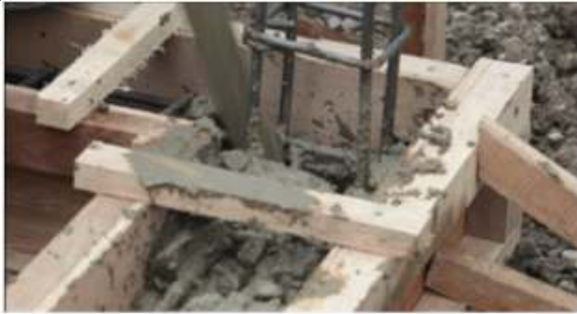
Gambar 58. Pengecoran Balok Pengikat/ Sloof
