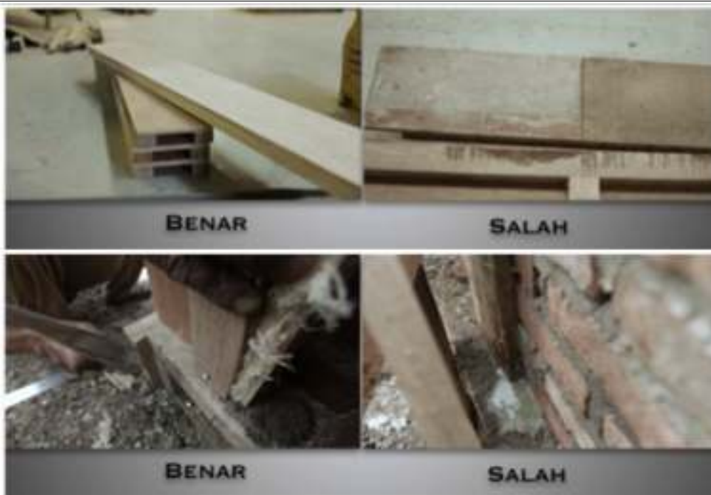
Gambar 54. Kualitas Cetakan/ Bekisting
