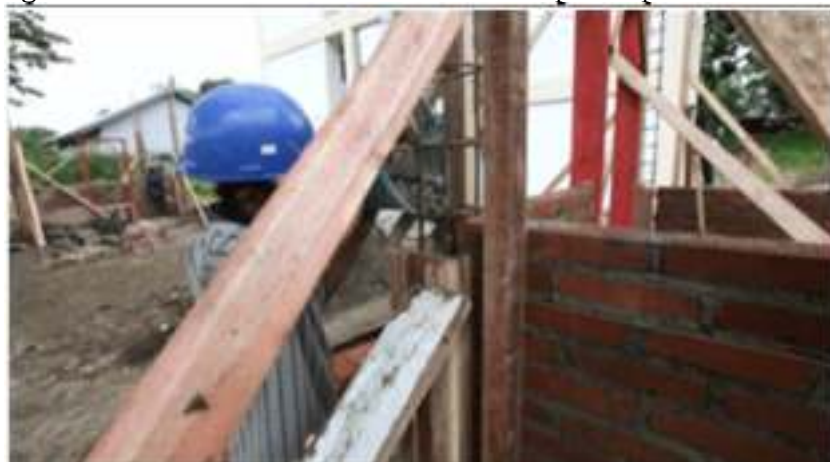
Gambar 56. Proses Pengecoran Kolom
