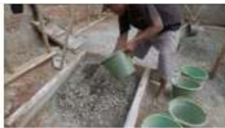
Gambar 2. Pencampuran Beton
