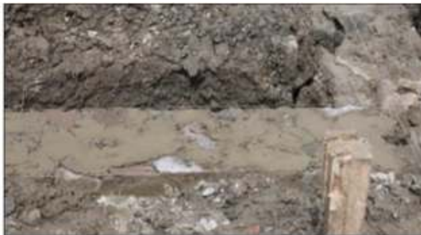
Gambar 11. Pondasi Dari Batu Kali/Gunung
