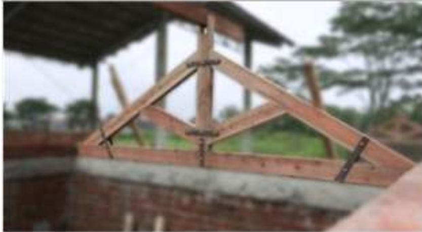
Gambar 28. Kuda-kuda Kayu Dengan Pengikat Plat Baja
