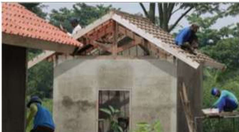
Gambar 27. Kuda-kuda Kayu Pada Atap Rumah Tinggal
