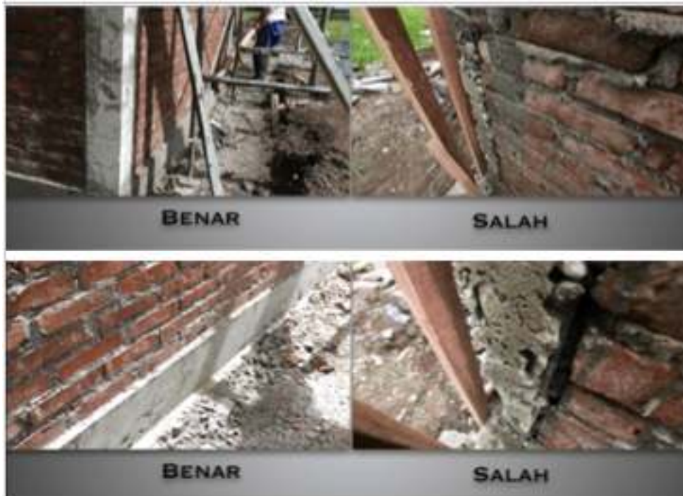
Gambar 58. Hasil Pengecoran
